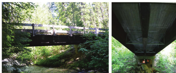
图 4 木-混凝土组合桥梁 (Salmon River Bridge) [33]
