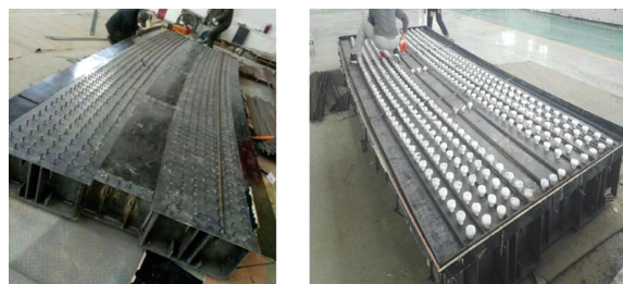
图 23 普通栓钉与抗拔不抗剪栓钉 [44]
