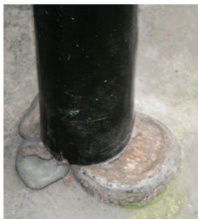
图 6 青城山祖师殿柱脚滑移 [30] (汶川地震 11 度)
