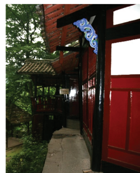
图 8 青城山真武宫柱架扭转 [30] (汶川地震 11 度)
