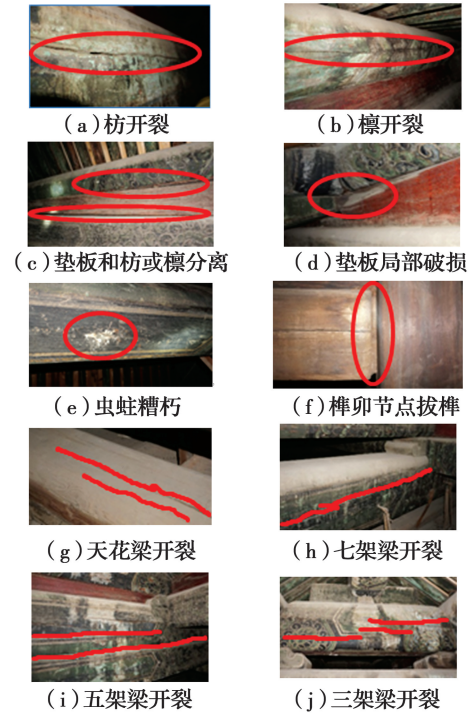
图 8 梁架层的残损
