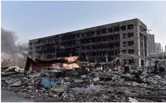
图 2 天津港爆炸中交警大楼损伤情况现场实拍 [40]
