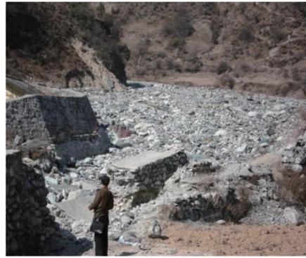
图 5 导流堤损毁后
