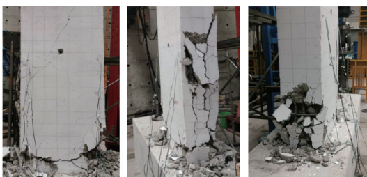
图 9 试件 SJ-4 破坏情况
