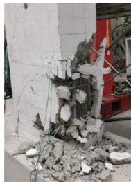
图 8 试件 SJ-3 破坏情况
