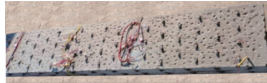
(a) 钢筋混凝土凿毛植筋
