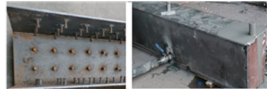
(b) 焊有剪力钉的外包钢板、灌浆
