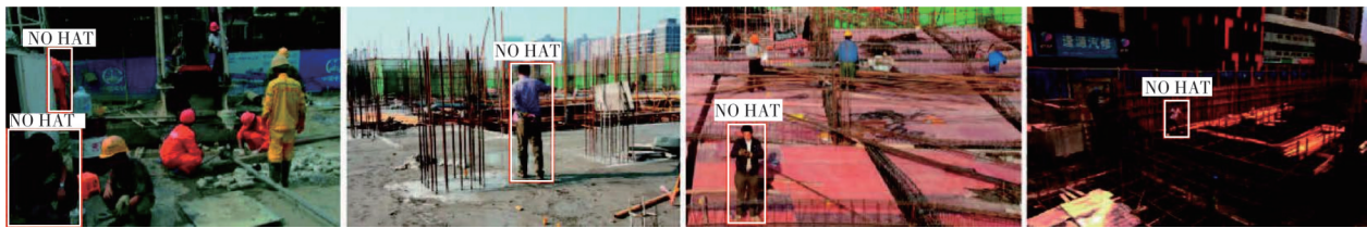
图 11 施工人员安全帽佩戴检测实例 [57]
