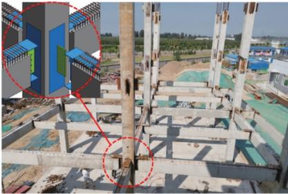
图4 装配式钢节点混凝土框架结构工程示范
