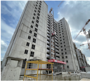
(a) 工地现场实景图
