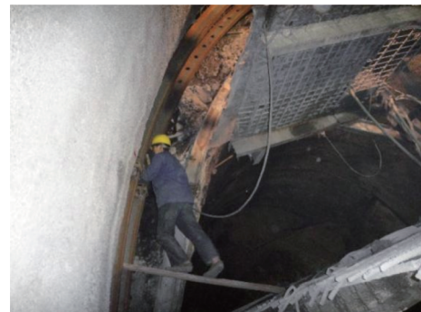
图16 隧道侵限段换拱
