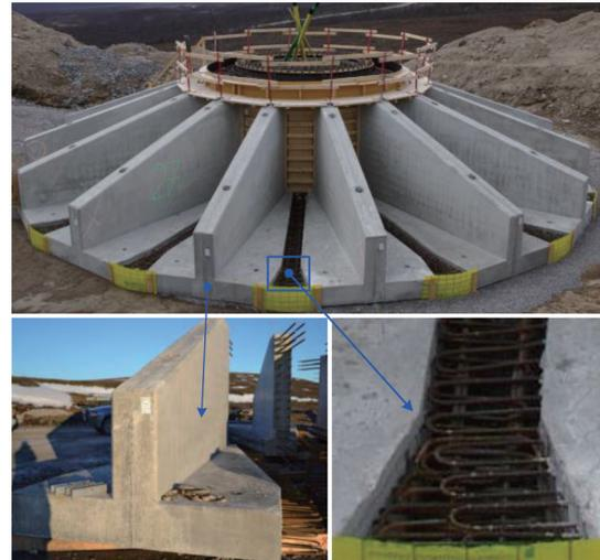
图3 瑞典 Sjisjka 陆上风电场现场施工<sup>[16]</sup>
