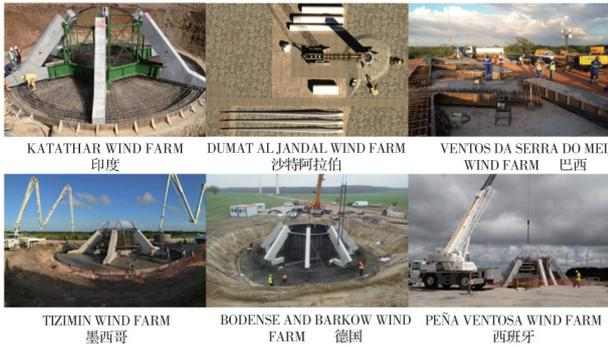
(b) 国外采用支撑基础的风电场
