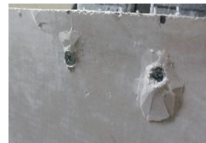
(b) 螺钉钉头沉入防火板
