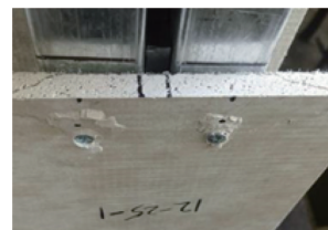
(c) 防火板端部与钉孔间形成贯通裂缝
