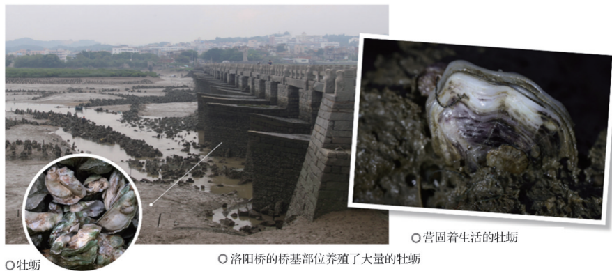
图 18 福建洛阳桥牡蛎固基 [105]
