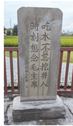
图 8 微生物加固修复后的红井纪念碑 [28]
