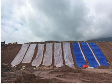
图 6 边坡微生物加固试验 [26]
