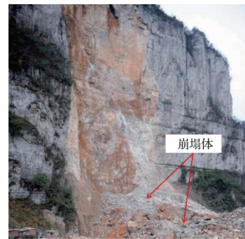
图3 土坡崩塌典型失稳图
