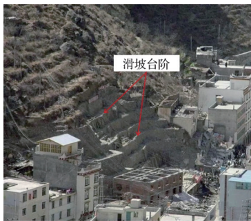
图2 阶梯状滑坡典型失稳图
