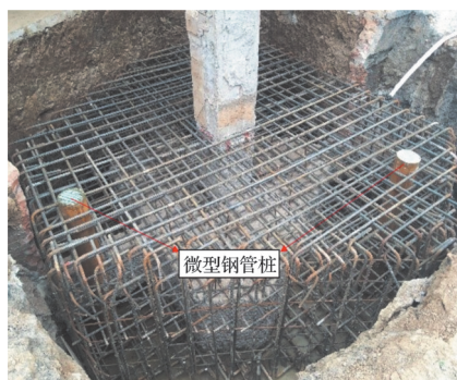
图1 现场微型钢管桩加固过程照片
