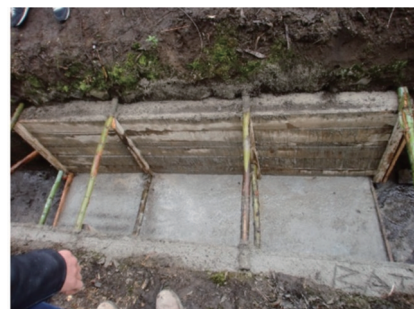
图 4 自愈混凝土浇筑的灌溉衬砌 [22]
