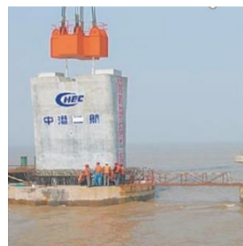
(b) 杭州湾跨海大桥
