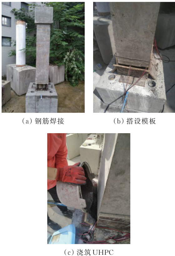
图7 现浇UHPC-榫卯混合连接
