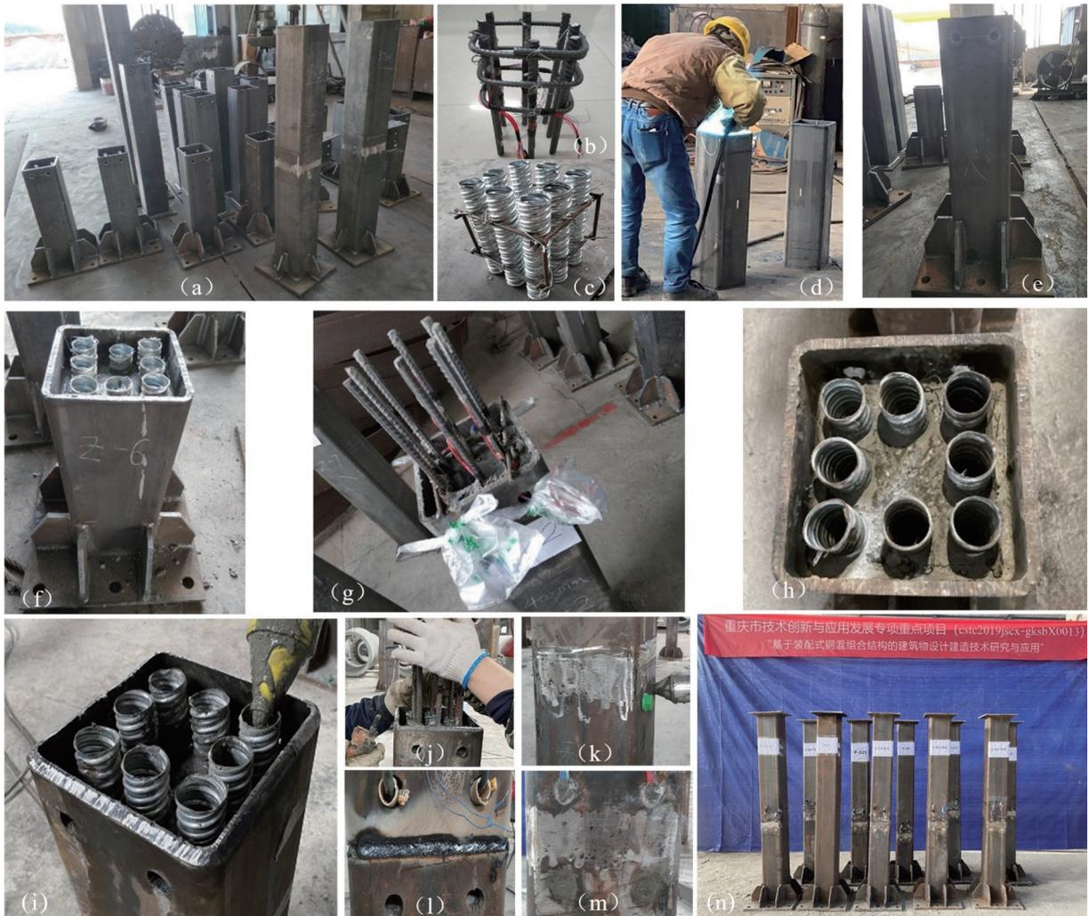
图 3 柱构件拼装流程示意图
