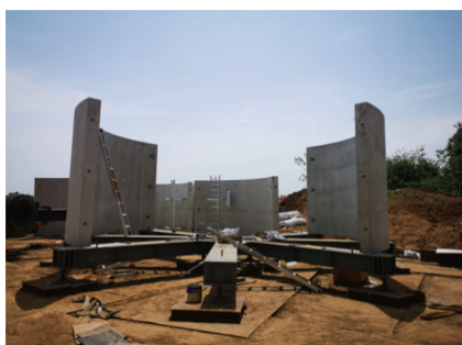
图21 混凝土管片拼装
