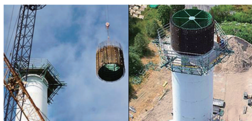
图 13 滑模施工
