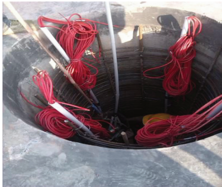
图 4 钢筋应力计安装现场图
