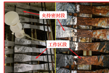
(a) 腐蚀前 (b) 腐蚀后
