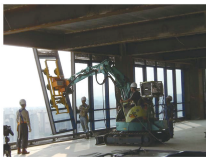
图 6 人工操控多用途安装机器人完成幕墙施工 [64]
