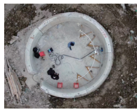
(a) 地铁小直径盾构单液浆
