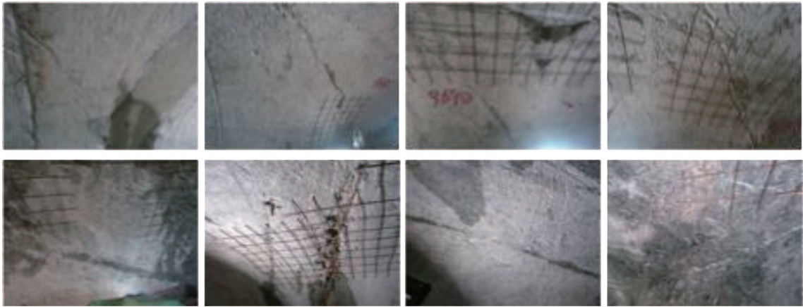
图 7 青岛地铁 6 号线 TBM 施工隧道围岩及其结构面图像
