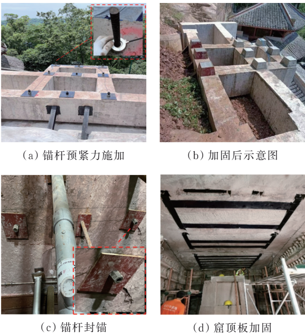
图 6 悬吊锚杆加固图
