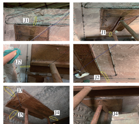
图4 顶板裂缝分布
