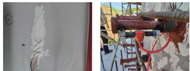
(a) 塔筒内壁应变片 (b) 焊钉应变传感器
