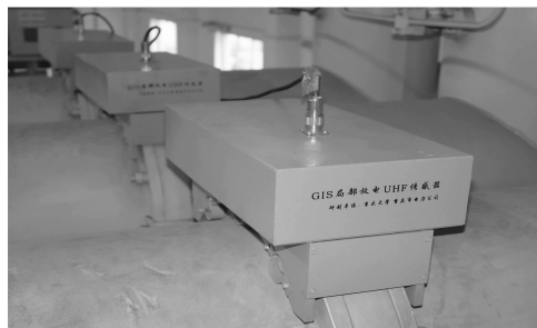
图 6 变电站微带天线安装示意图
