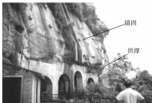
图12 竣工后的危岩支撑—锚固联合治理
