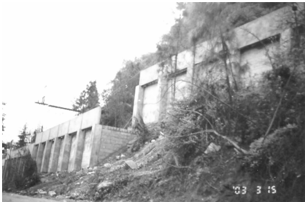
图 14 太白岩中段危岩拦石墙
