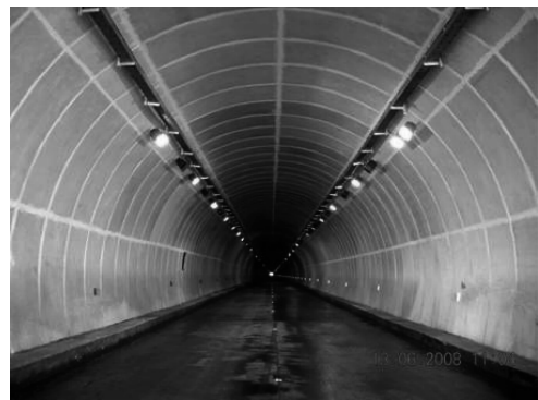
图 14 处治结束后的大坂山隧道
