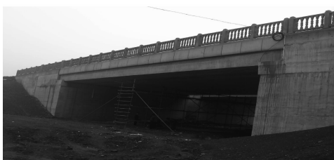
图 7 华福桥桥梁立面
