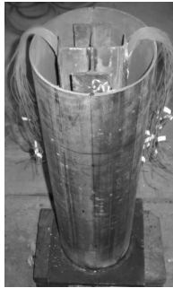
图 1 焊接的试件钢骨架
