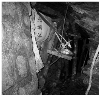
图4 柔性模板泵送煤矸石胶结充填材料现场试验效果
