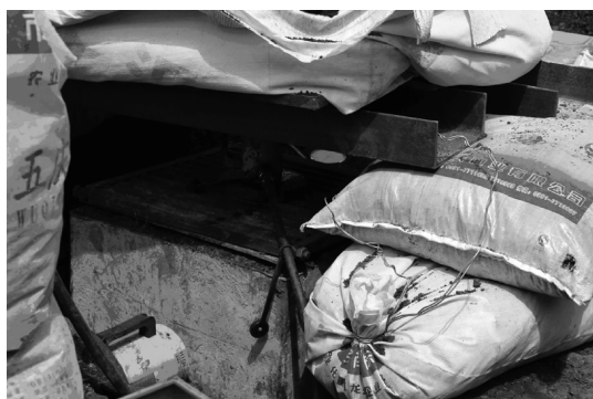
图 3 现场大型剪切试验
