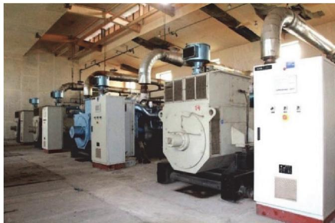
图 10 瓦斯发电机组
