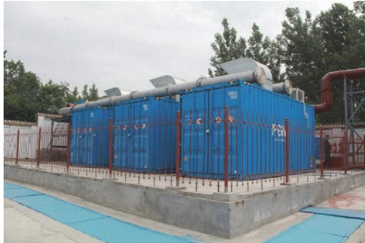
图 7 集装箱式智能瓦斯抽采设备现场图
