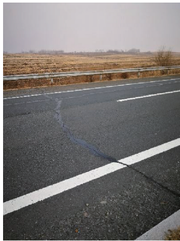
图 3 长吉高速沥青表面层贯穿裂缝
