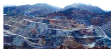
图 7 边坡整体面貌
