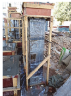
(b) 浇筑混凝土
