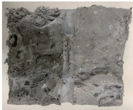
图5 试件内部破坏情况
