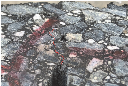
图 7 局部裂缝放大示意图 Fig. 7 Schematic diagram of enlarged partial cracks
