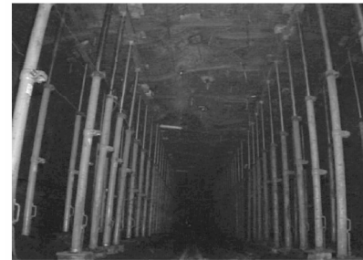
图 9 赵固二矿 1105 切眼现场照片
