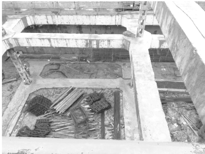
图 5 漕河泾商业服务区基坑
