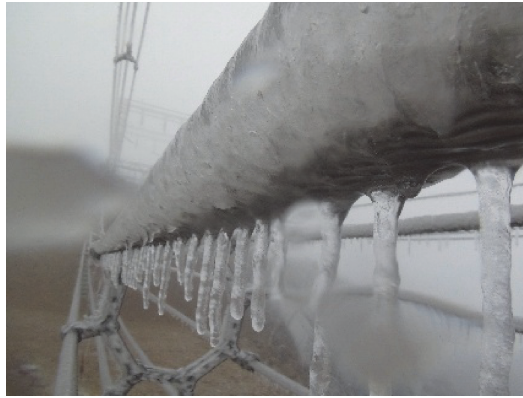
图 10 导线雨淞覆冰时形成的冰棱
