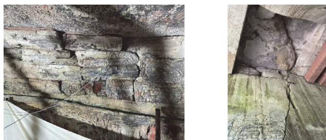
图1 大足石刻石窟裂隙
