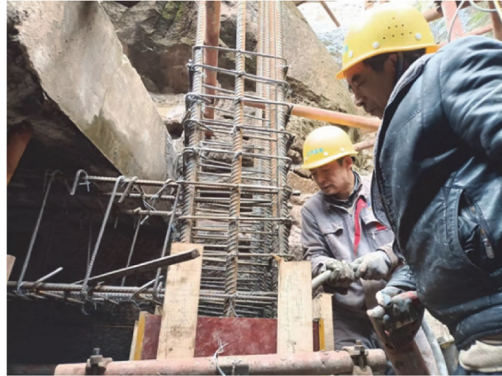
(c)小横梁、支撑墙钢筋绑扎
