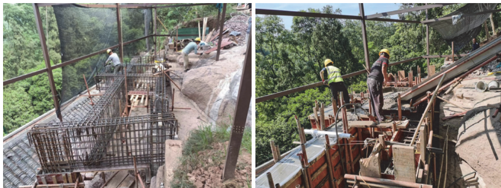
图19 悬吊梁钢筋绑扎及浇筑
