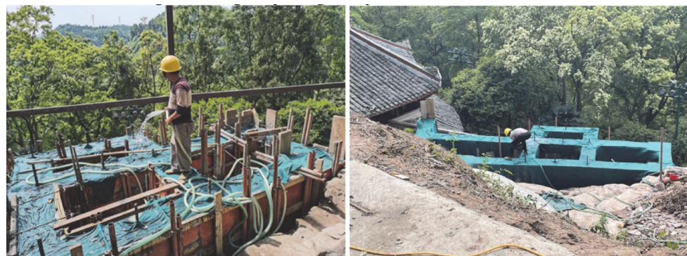
图20 悬吊梁养护
