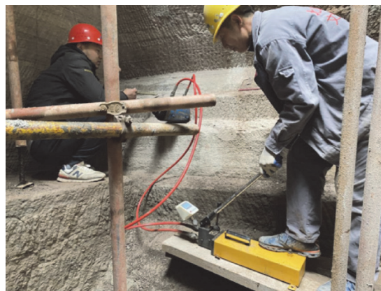
图14 锚杆拉拔试验
