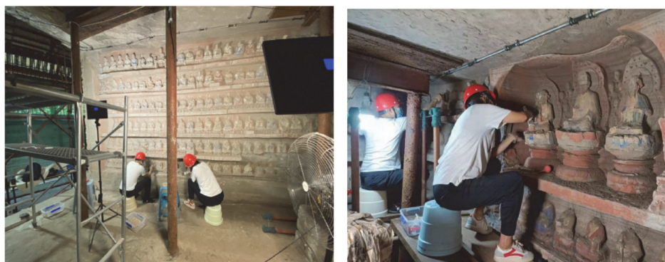
(a) 造像本体裂隙填充
