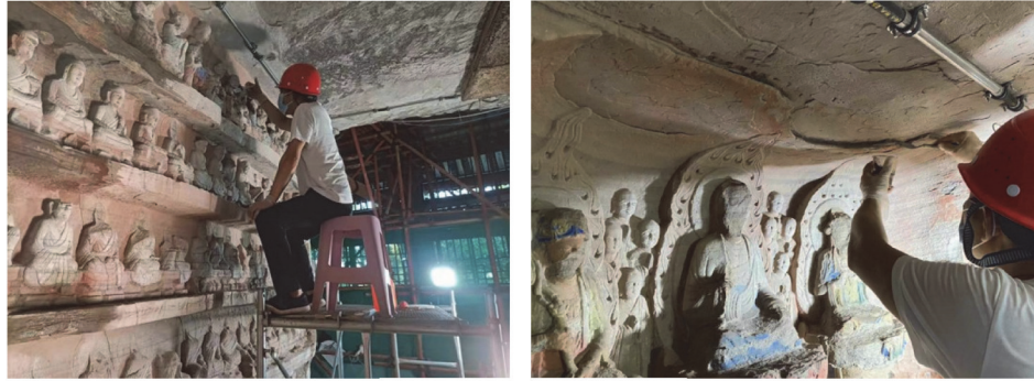
(b) 造像本体裂隙填充
