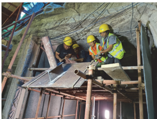
图21 原支撑钢板拆除
