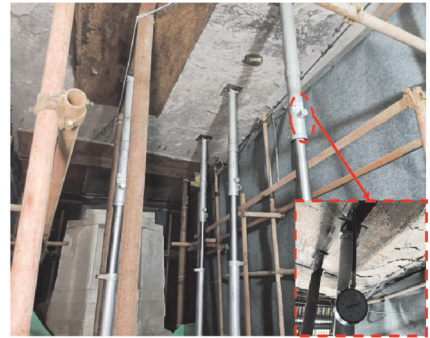
图 17 窟内液压支柱压力盒安设
