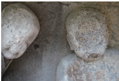
图 4 粉化、剥落
