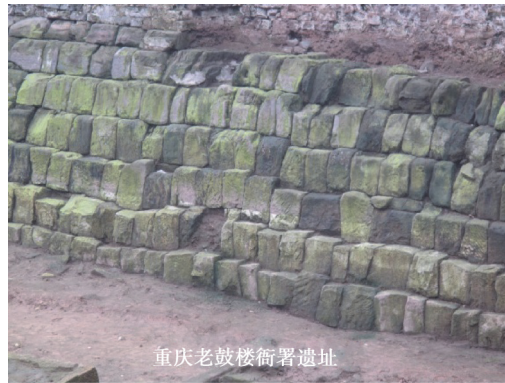
图 9 石材表面生长微生物
