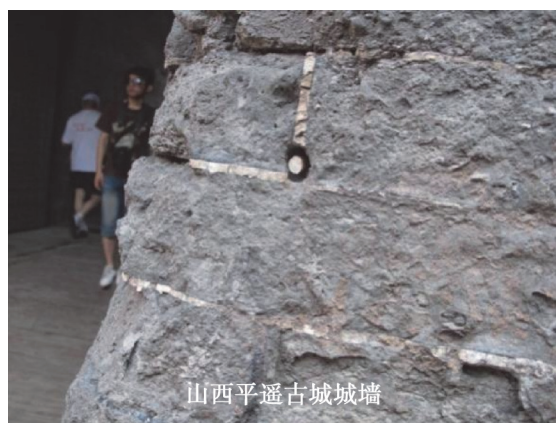
图7 典型化学因素产生砖石文物病害
