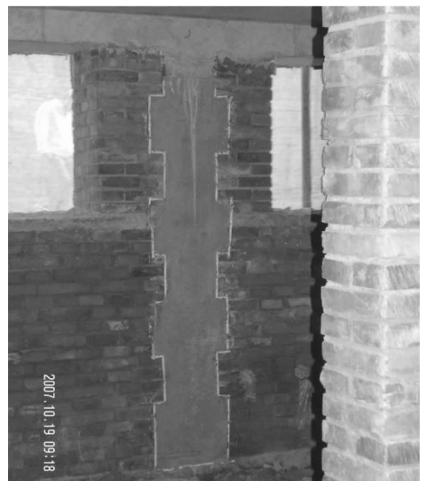
图1 构造柱马牙槎
