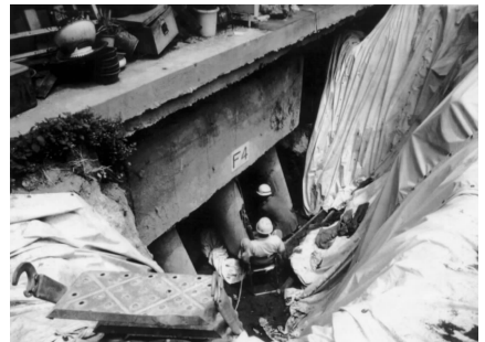
图2 1995年日本神户地震地下基础破坏
