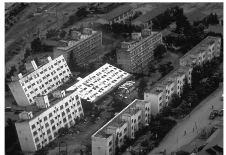
图1 1964年日本新潟地震液化倒塌
